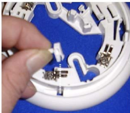
6. ábra. A záró pecek helyére illesztése
